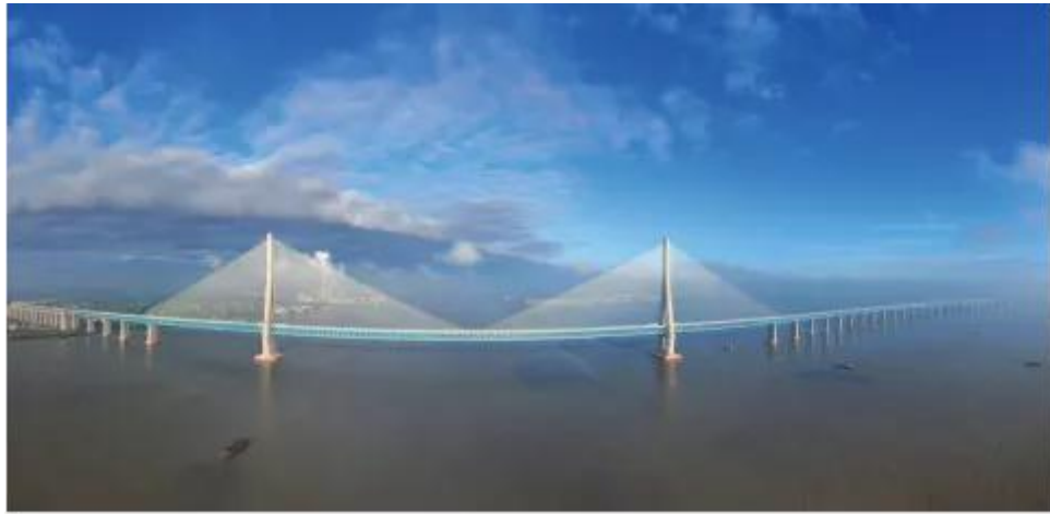
图 世界首座跨度超千米级公铁两用斜拉桥—沪苏通长江公铁大桥
