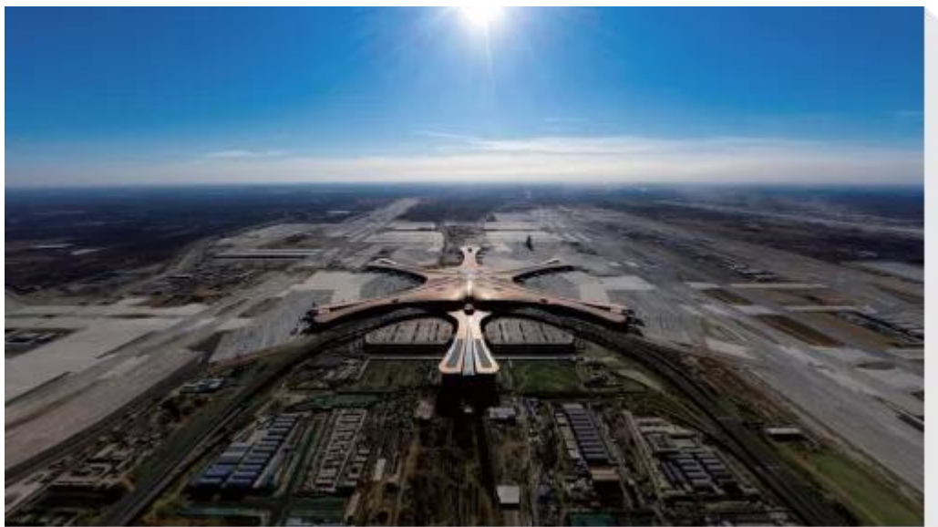
图 北京大兴国际机场
