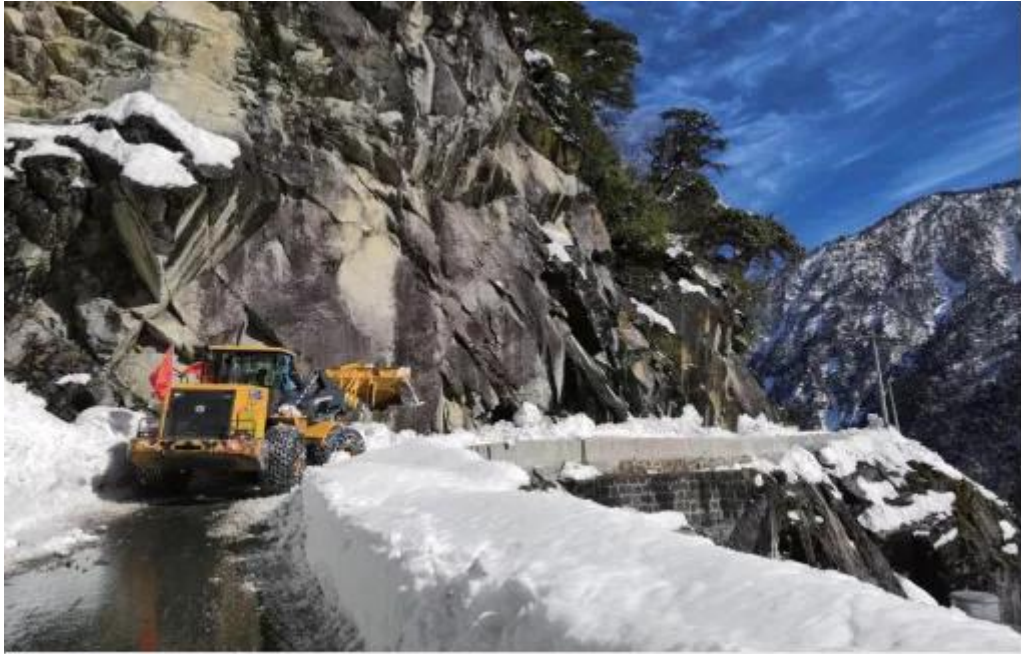
图 实施公路抢通作业
