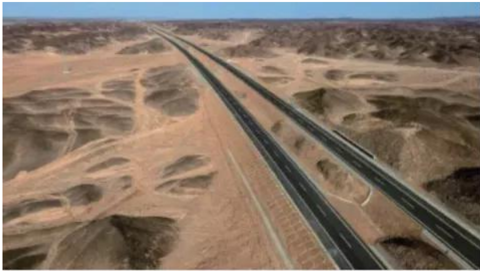
图 穿越沙漠的高速公路—京新高速公路
