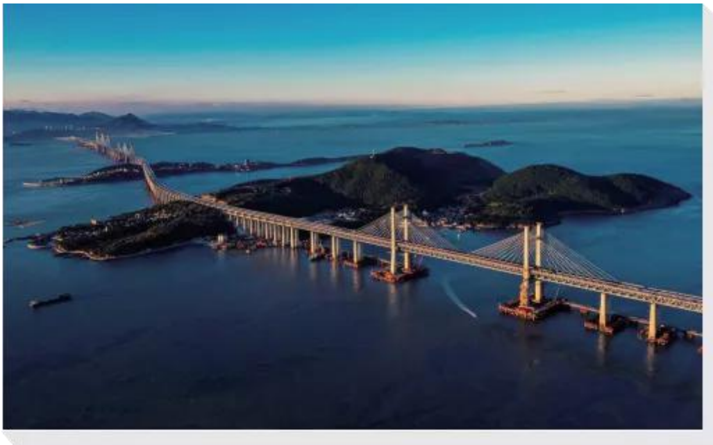
图 福建省平潭海峡公铁两用大桥
