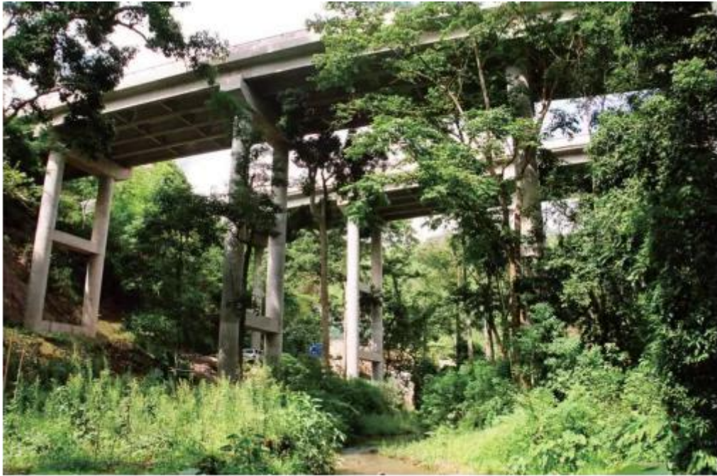
图 在热带雨林中建成的云南省思茅至小勐养高速公路
